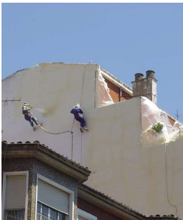
La gran adherencia del poliuretano proyectado hace que no requiera de ningún otro sistema adicional de sujeción.
